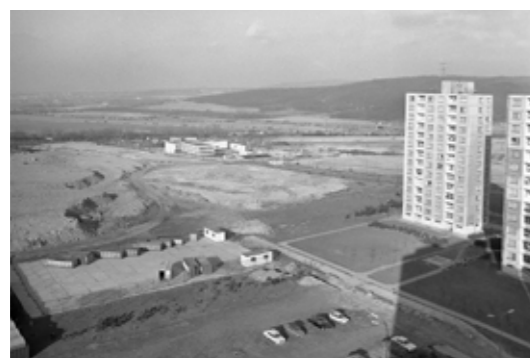
foto z výstavby KBV
